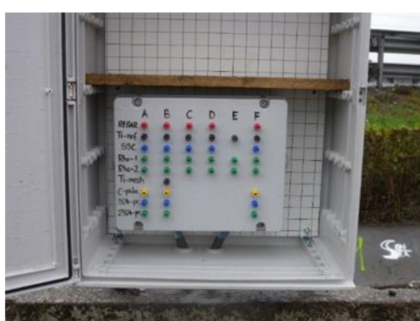
Quadro elettrico con i collegamenti agli elettrodi e alle sonde interne
